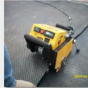
Geomembrane - Welding
